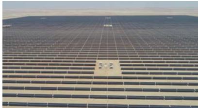
125MW Oman, 2019 Japon Marubeni Centrale photovoltaïque bifaciale de type N Oman
