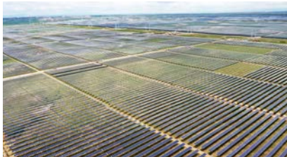
253MW Gonghe, Qinghai, Chine, 2020 Base n ° 2 de la centrale photovoltaïque UHV
